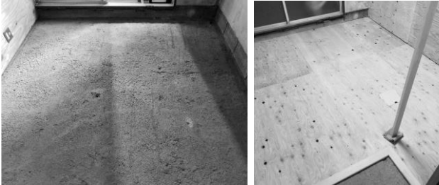
写真 1 既存床面 写真 2 施工後床面
